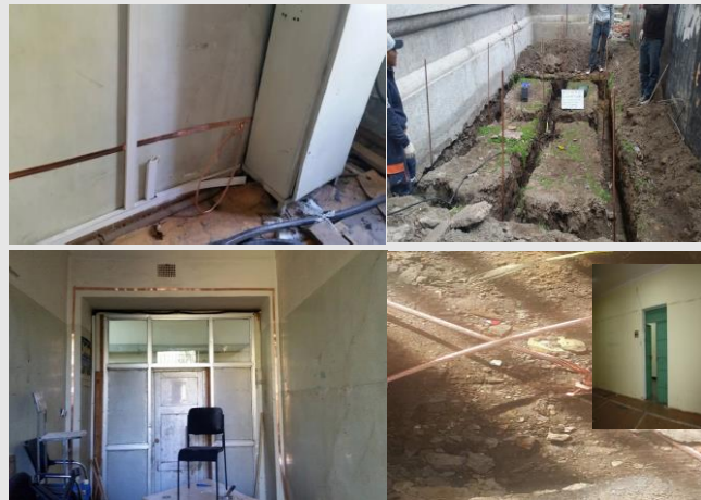
ШУС-ийн засвар /гадна тохижилт
